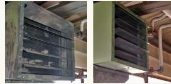
Levo: 25 let star toplotni izmenjevalec - pred čiščenjem. Desno: toplotni izmenjevalec očiščen s tehnologijo suhega snega - dry snow.
